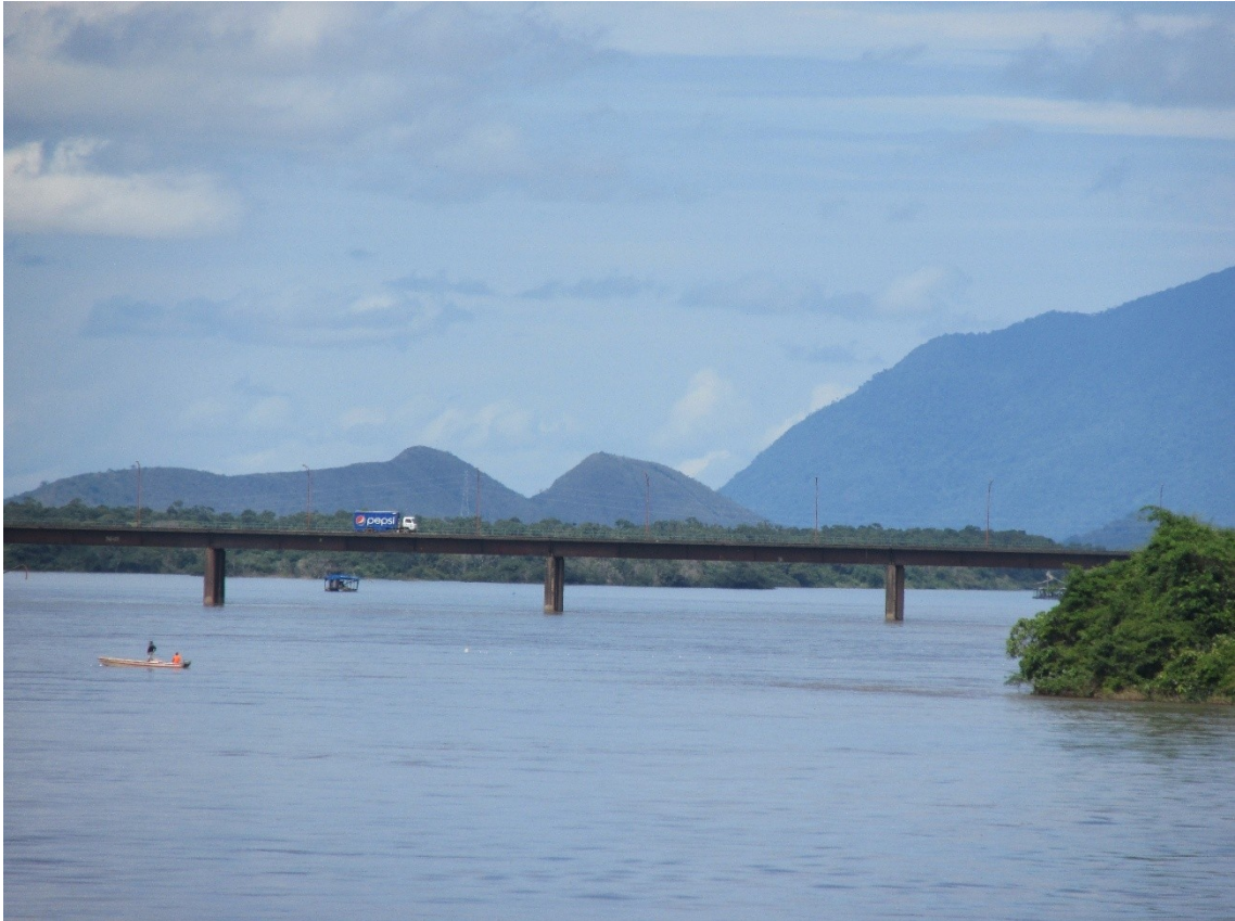
Ponte sobre o rio Branco, afluente da margem esquerda do Amazonas. Boa Vista-RR / Brasil (02°48'N , 60°40'W) Paisagem de Clima Equatorial Seco Amazônico Setentrional (Eq**nam).
