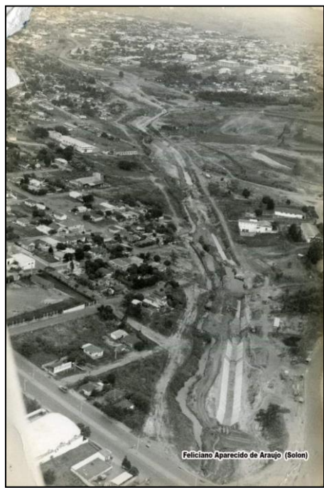
Figura 5 A - Construção do Parque do Povo e canalização do Córrego do Veado na Gestão do Prefeito Paulo Constantino (1977-1980).
