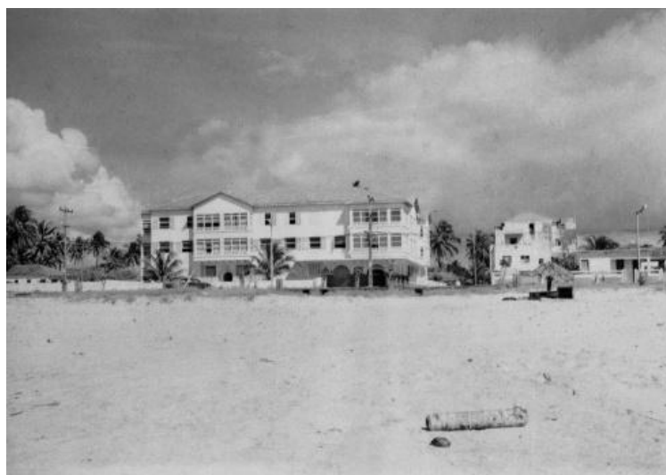
Figura 3 - Vista do Edifício Oceania de frente para praia de Boa Viagem.
