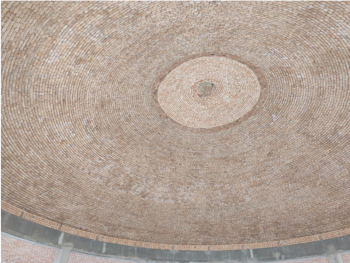
Figura 15 - Telhado em cúpula visto do lado de dentro.
