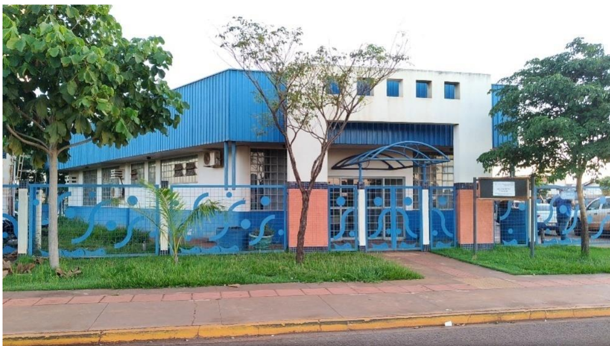
Figura 21 - Vista do prédio da atual Secretaria da Agricultura Familiar do município de Dourados.
