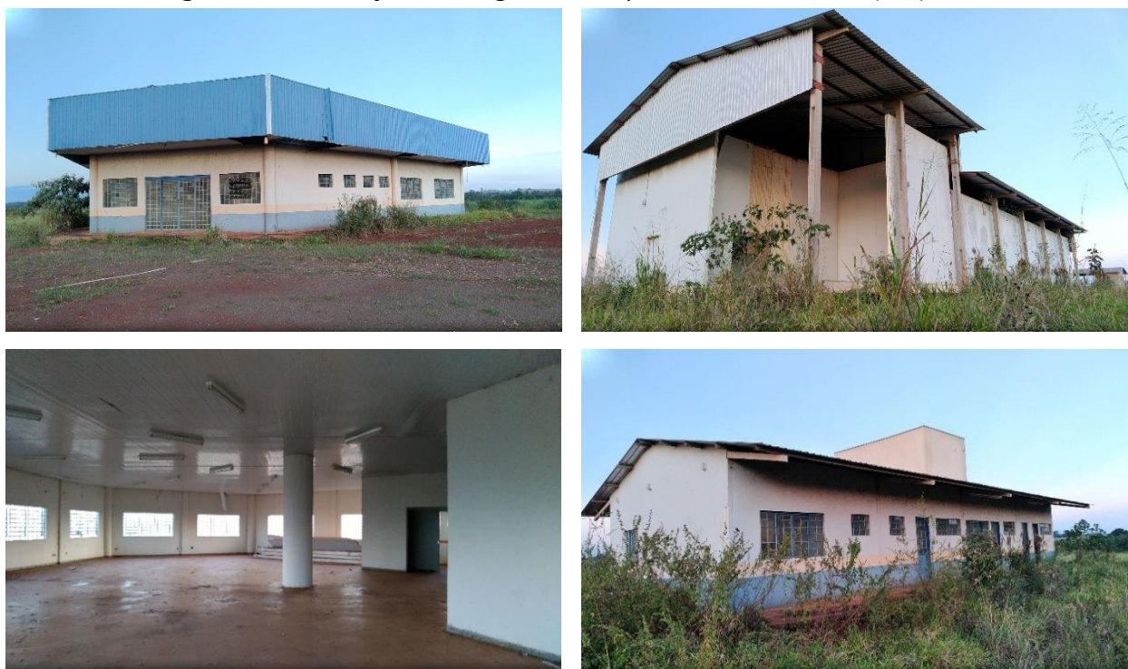
Figura 18 - Instalações do frigorífico de peixes em Dourados (MS).
