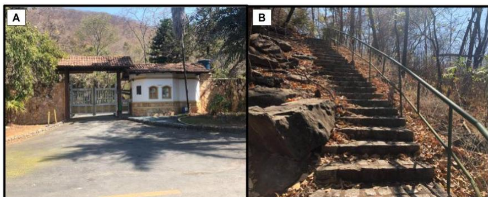
Figura 3 - Estrutura de Apoio do Parque. (A) Portaria principal; (B) Escadaria.
