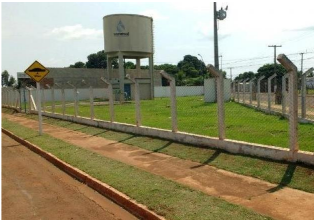
Figura 30 - Nova estação de tratamento de água em Jardim-MS.
