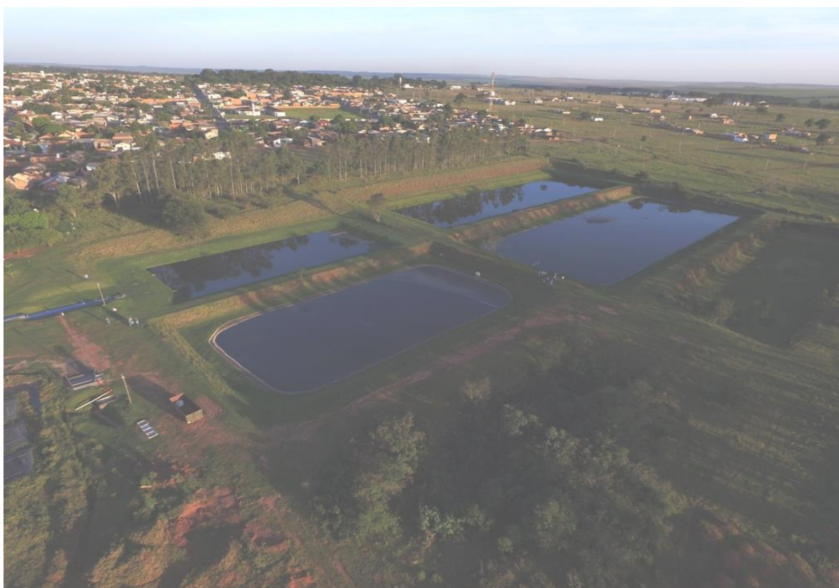
Figura 31 - Investimentos em Saneamento Básico (ETE) no município de Naviraí-MS.
