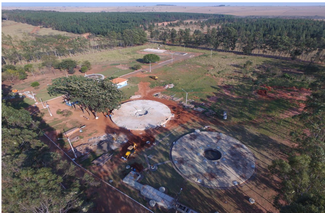
Figura 34 - Construção de Estação de Tratamento de Esgoto ETE em Nova Andradina-MS.
