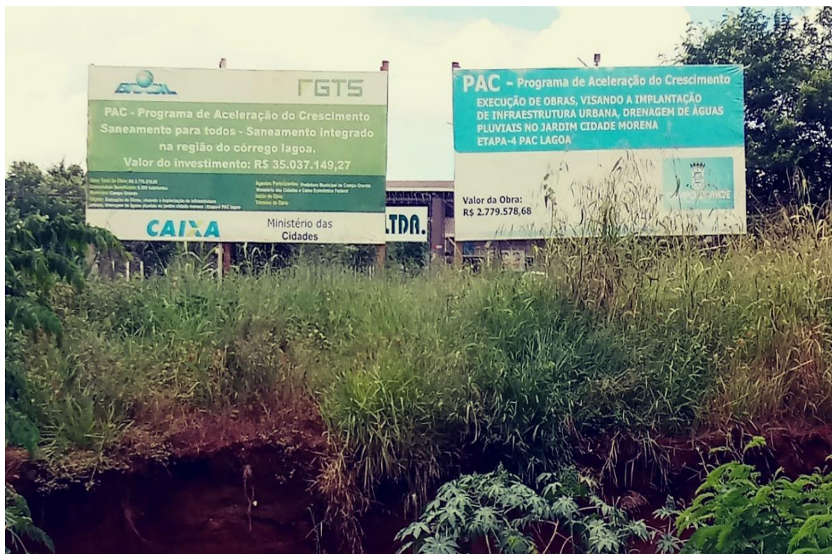
Figura 13 - Obras de Drenagem na Região das Moreninhas (Campo Grande-MS).
