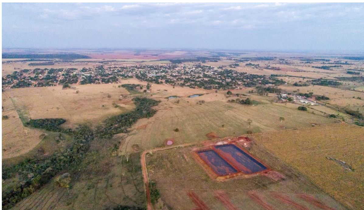
Figura 17 - Construção da Estação de Tratamento de Esgoto – ETE em Juti-MS.
