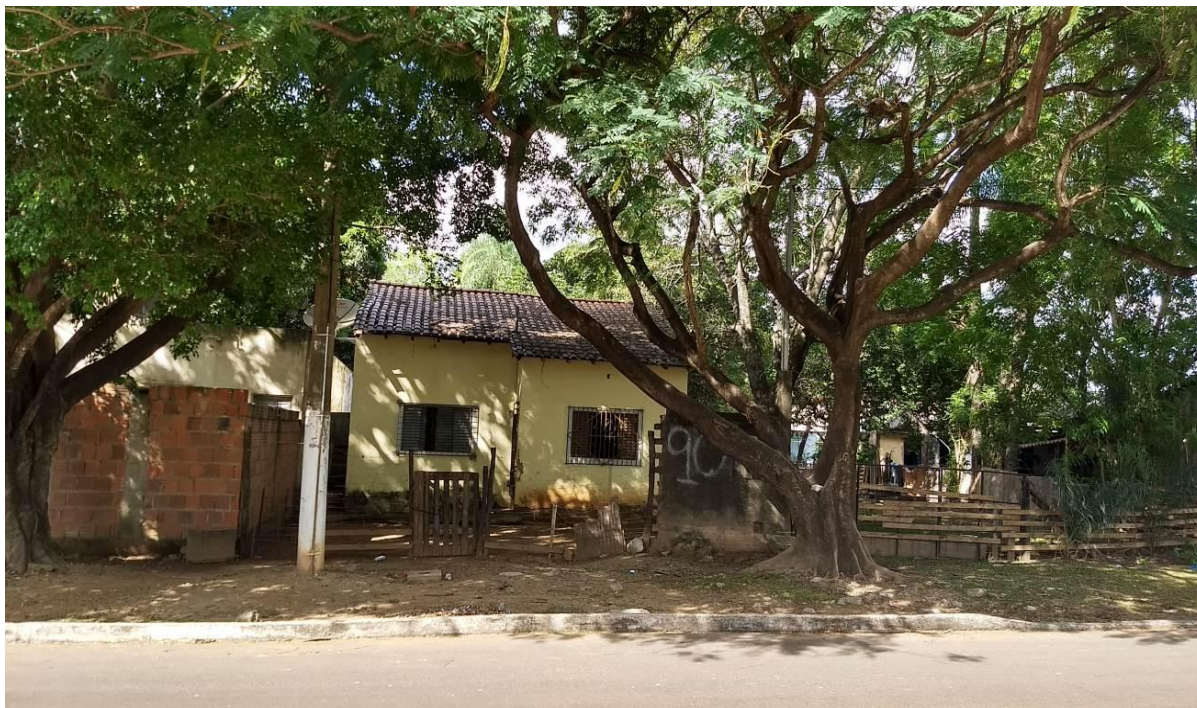
Figura 47 – Agrupamento das moradias mais novas e construídas de alvenaria (1980).
