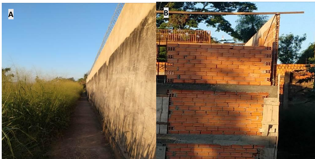
Figura 44 – Barreira de isolamento. Edificação de muro no acesso a comunidade.
