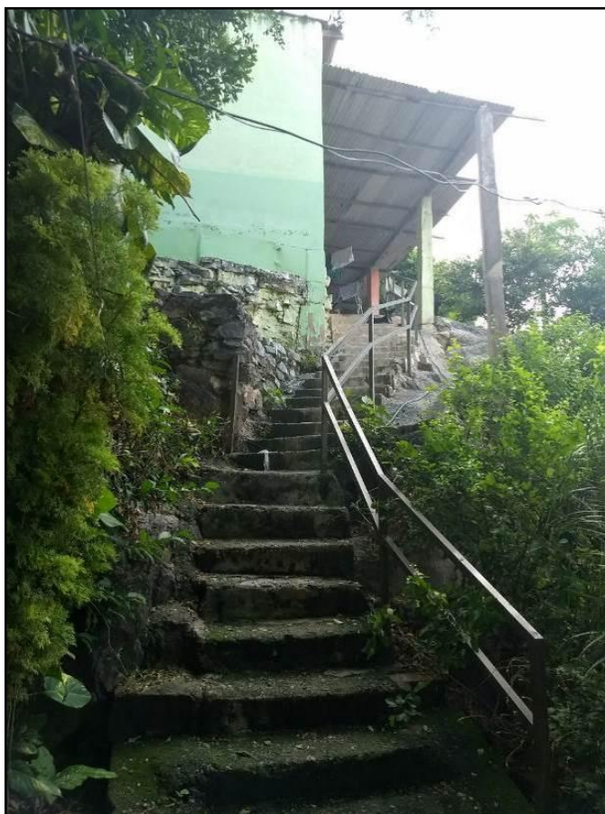
Figura 39 – Escadaria de acesso à moradia n.º 6.
